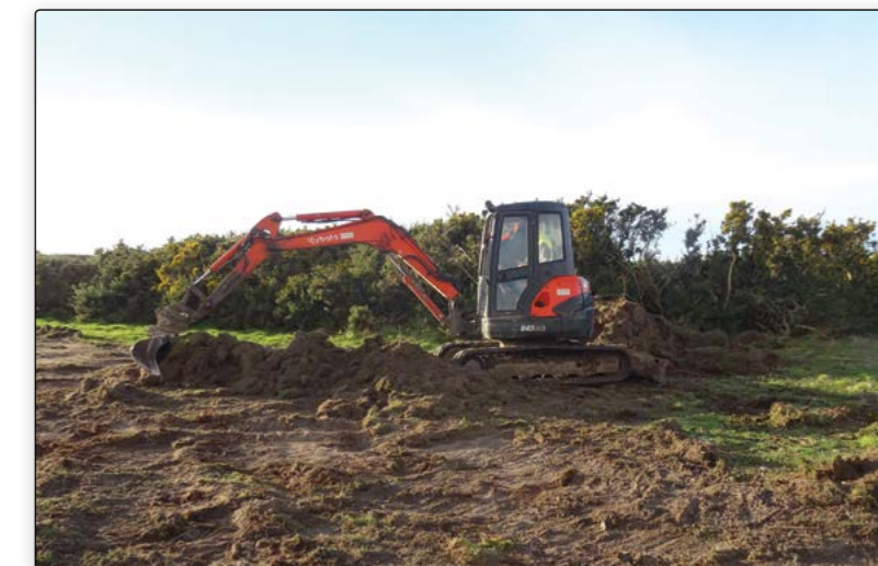
Travaux d'étrépage sur le communal d'Écault
